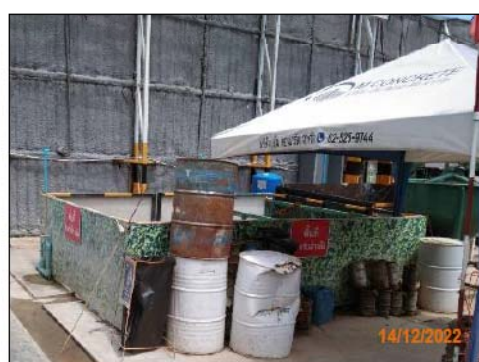
ภาพที่ 2.2-23 ทำความสะอาดบ่อตักดินตะกอน
